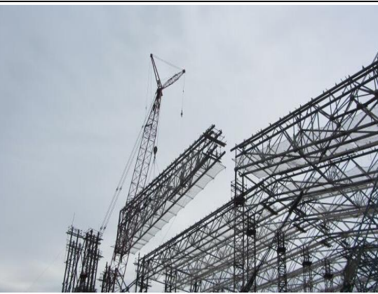
Door Truss Hoisting
